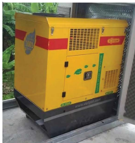
Trạm viễn thông BTS
