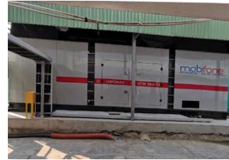
Tòa nhà Mobifone NOC Đà Nẵng
