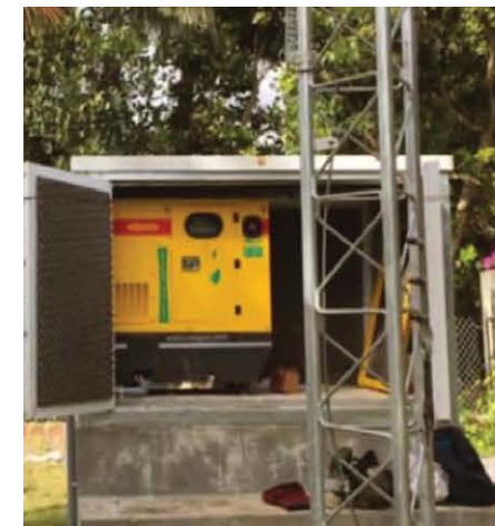
Nhiều tổ máy phát điện 8 - 12k VA
